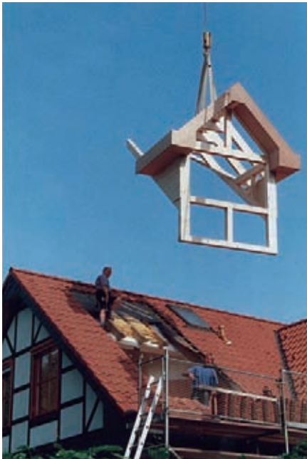
Patientenzimmer werden durch Dachgauben erweitert, 2006
